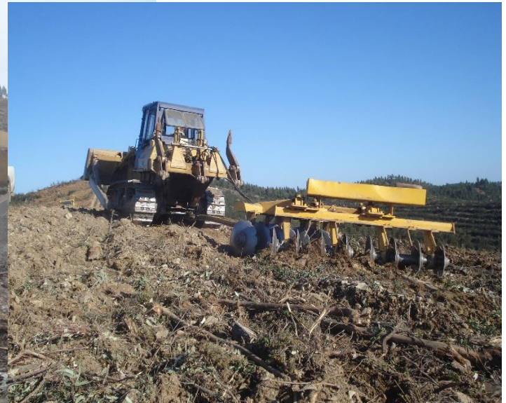
Bulldozer de 170 cv Grade de 5 – 7 ton
